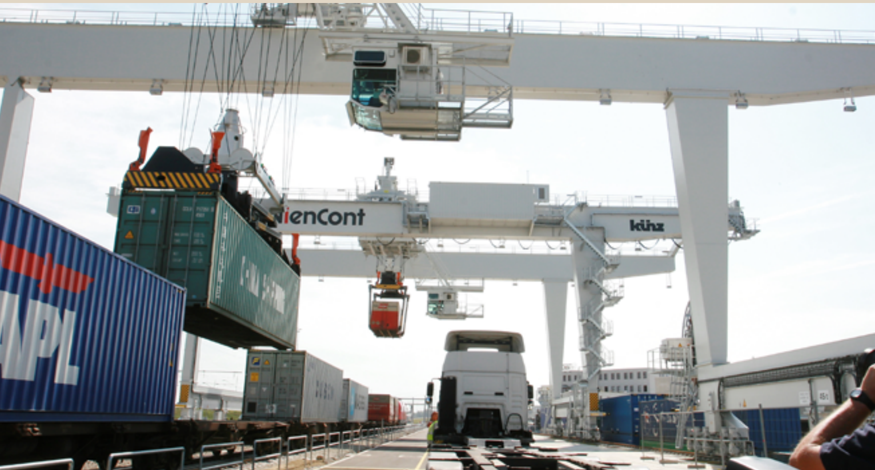
Containerterminal Hafen Wien. (Foto: Wien Holding / Hafen Wien / HJS archive)
